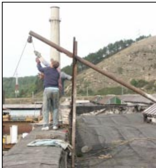
(Repararea acoperișurilor se află în plin progres pe platforma industrială Călnicel)
